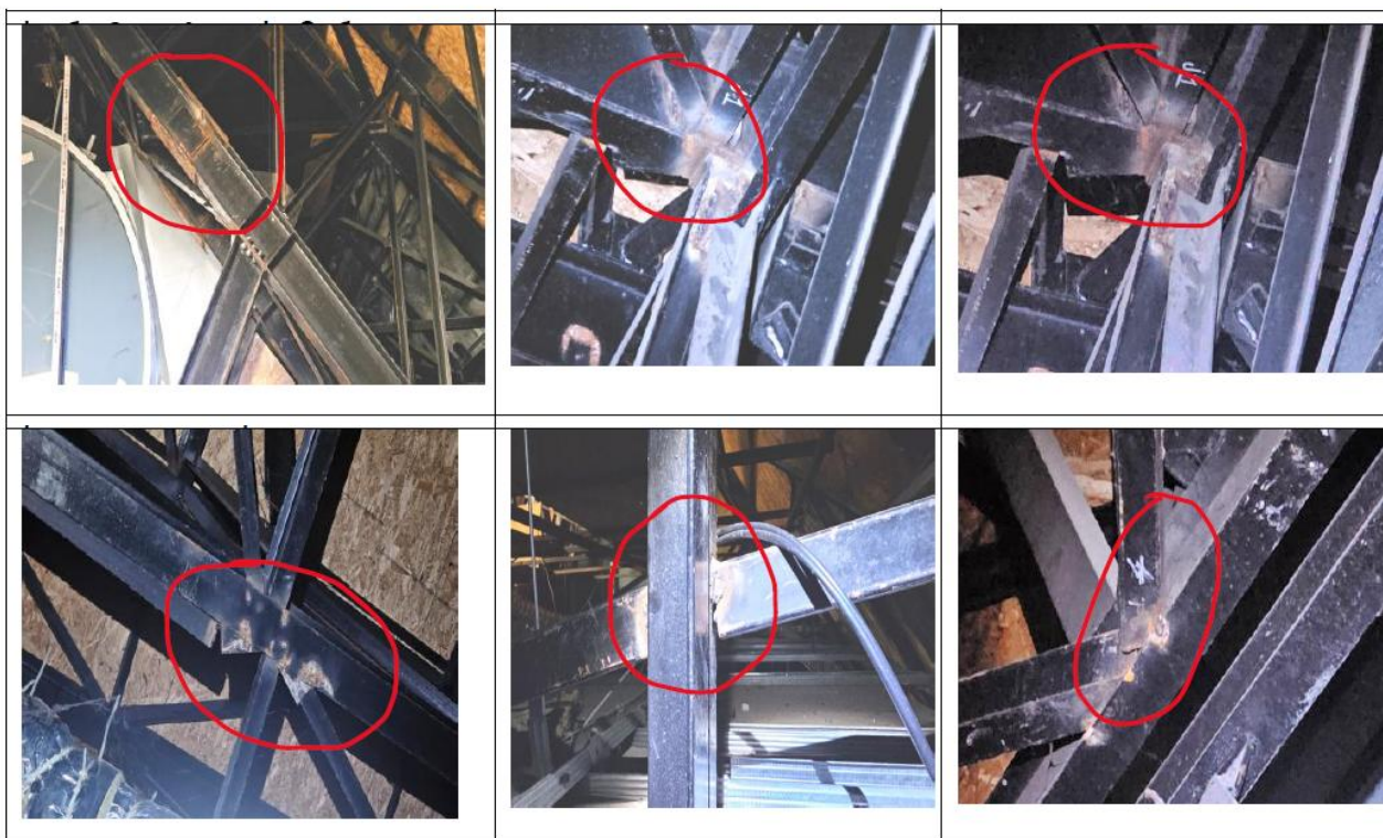
სურ. 10. გადახურვის ლითონ-კონსტრუქციებში კოროზიული დაზიანებების გამოსახულება.
