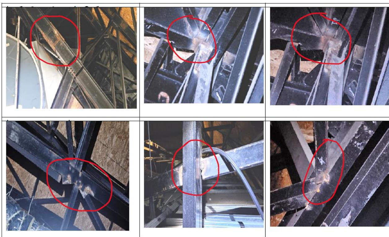
სურ. 10. გადახურვის ლითონ-კონსტრუქციებში კოროზიული დაზიანებების გამოსახულება.
