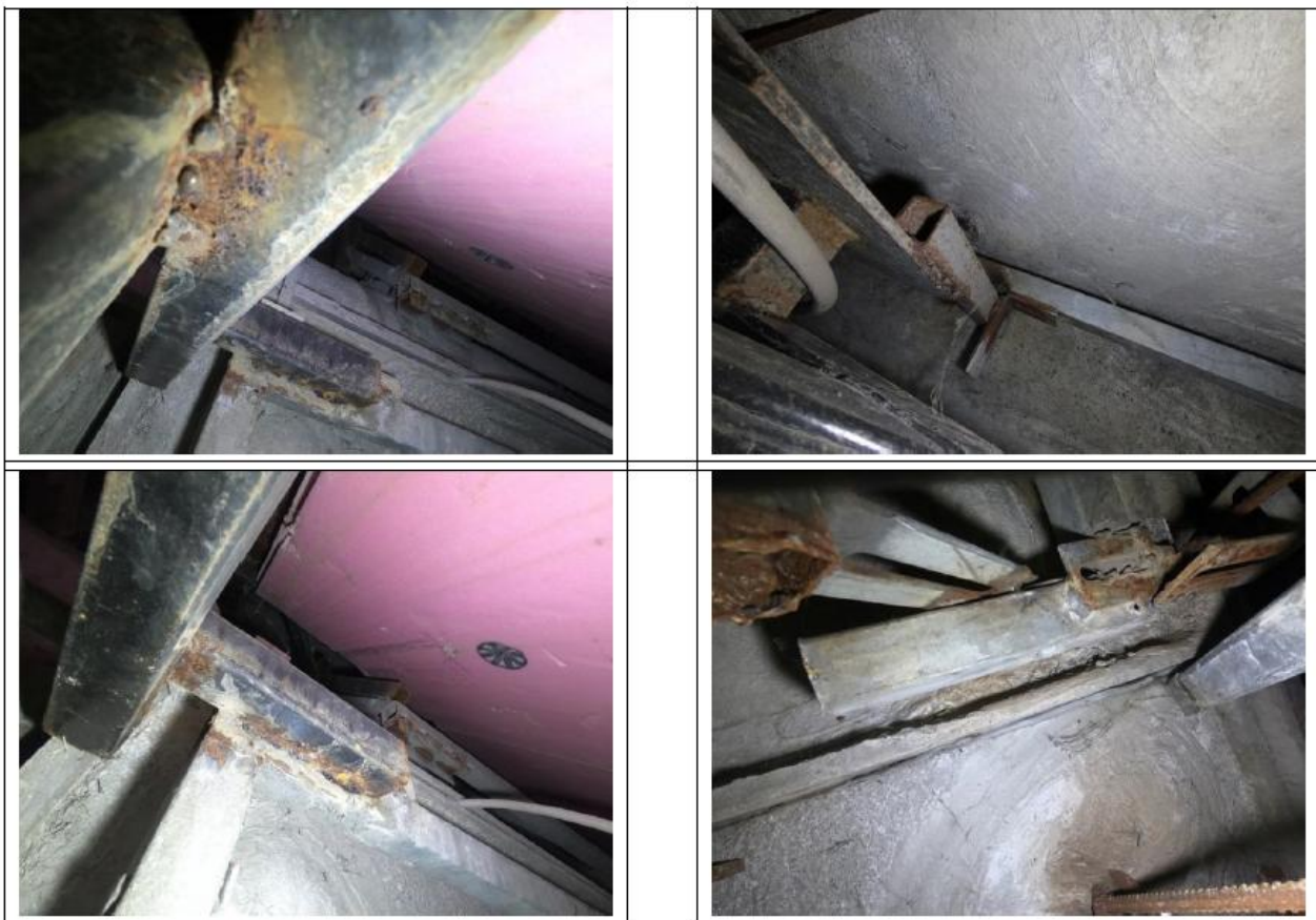
სურ. 14. სანიტარული კვანძის ლითონ-კონსტრუქციებში კოროზიული დაზიანებები.
