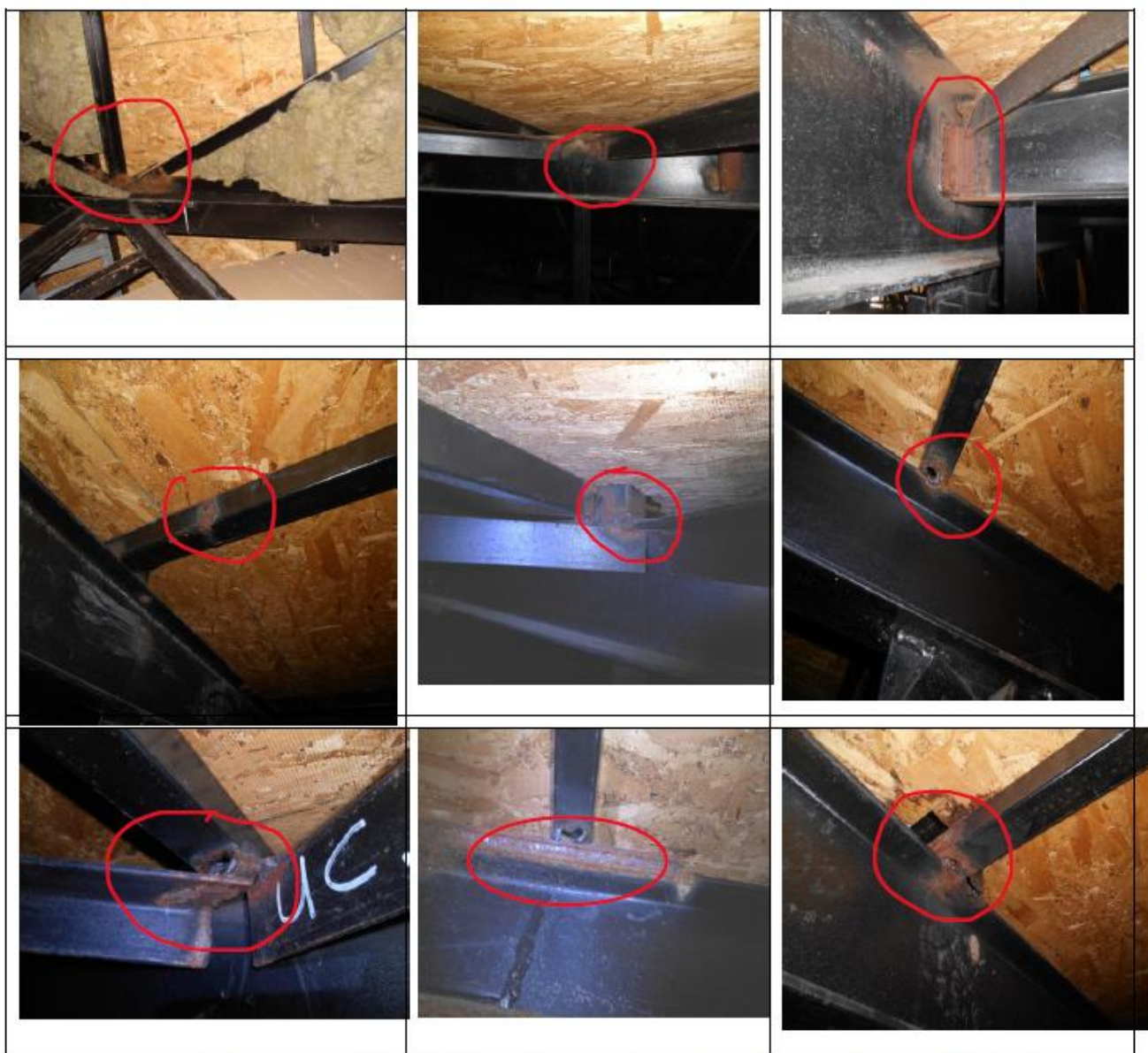
სურ. 8. გადახურვის ლითონ-კონსტრუქციებში კოროზიული დაზიანებების გამოსახულება.
