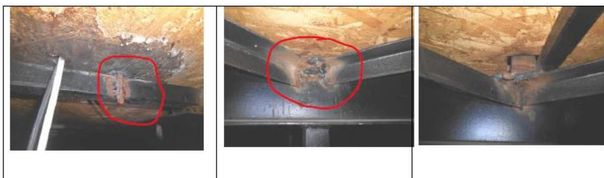
სურ. 9. გადახურვის ლითონ-კონსტრუქციებში კოროზიული დაზიანებების გამოსახულება.
