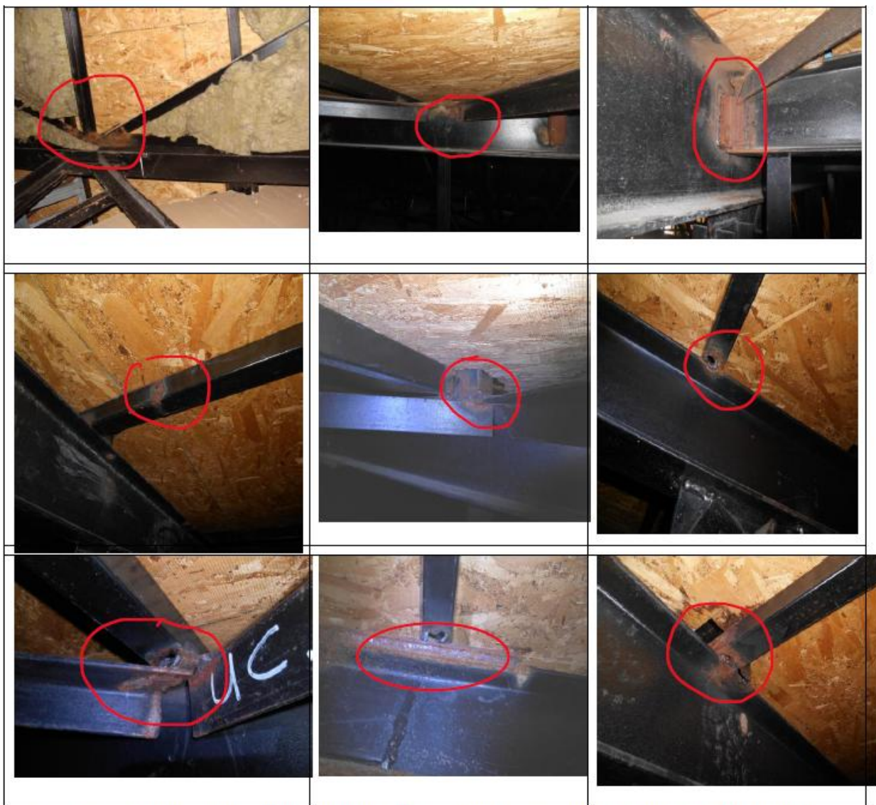
სურ. 8. გადახურვის ლითონ-კონსტრუქციებში კოროზიული დაზიანებების გამოსახულება.
