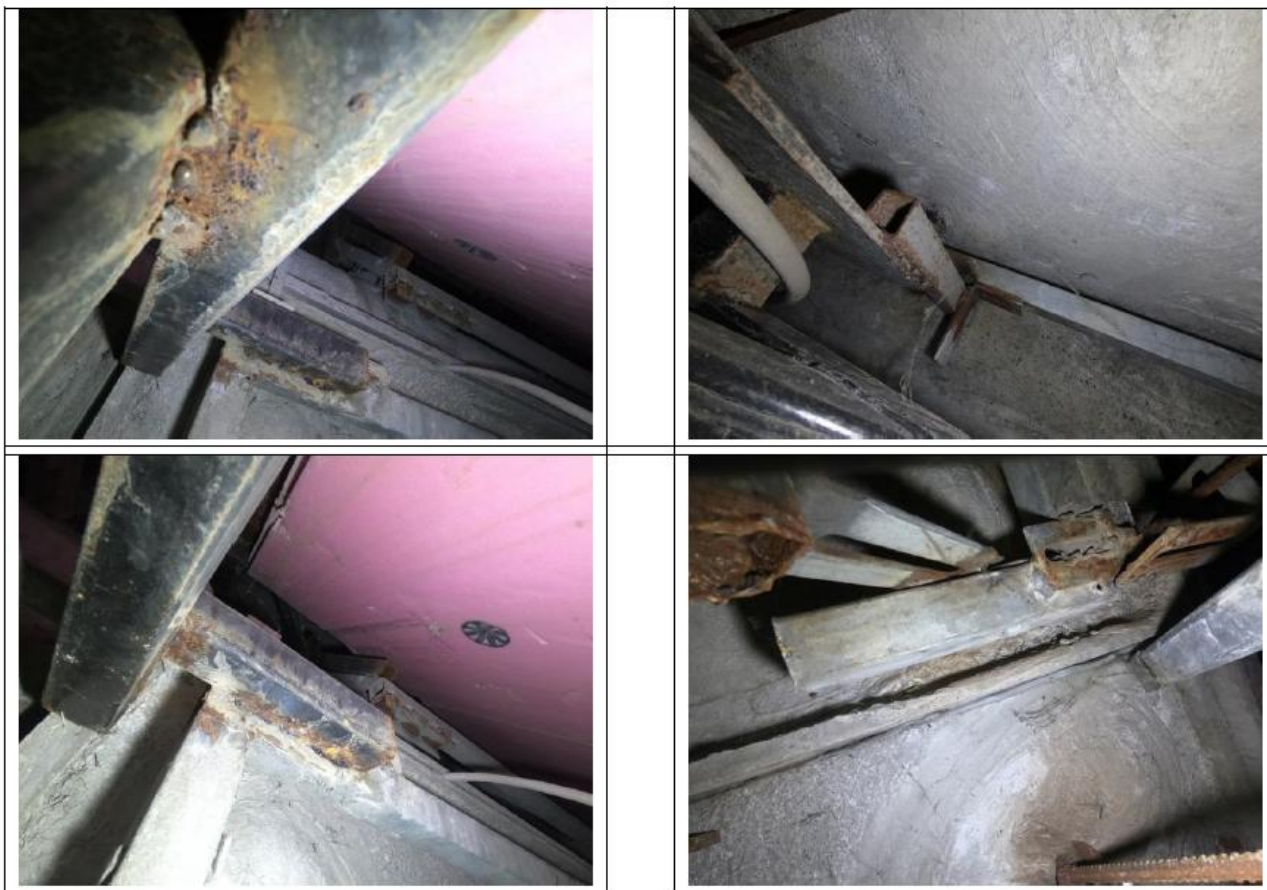
სურ. 14. სანიტარული კვანძის ლითონ-კონსტრუქციებში კოროზიული დაზიანებები.
