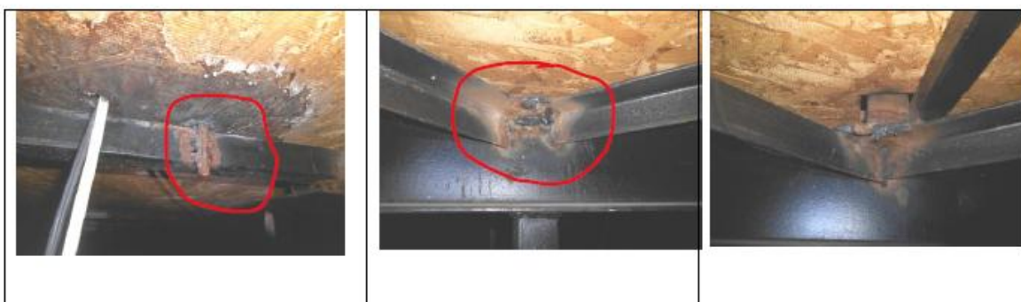
სურ. 9. გადახურვის ლითონ-კონსტრუქციებში კოროზიული დაზიანებების გამოსახულება.
