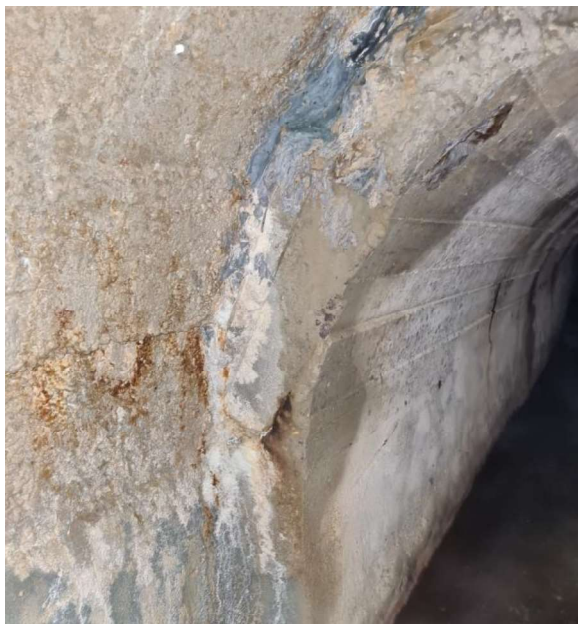
დაზიანებული სამშენებლო ნაკერები - სურათები N7 და N8
