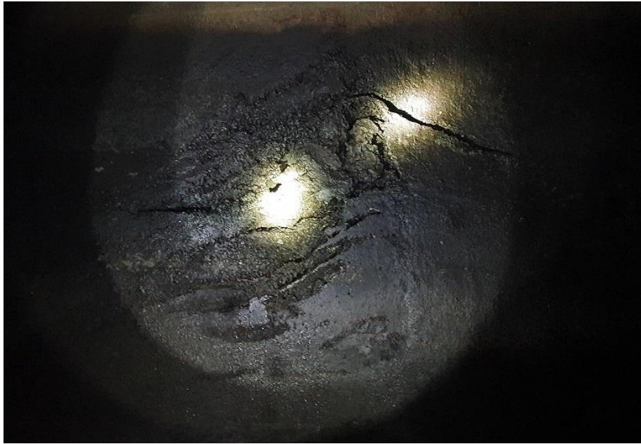
ფოტო 6-2: გვირაბში არსებული ეროზირებული უბნები: დრმად ეროზირებული მონაკვეთი, პკ 47+15 (30 სმ-მდე)
